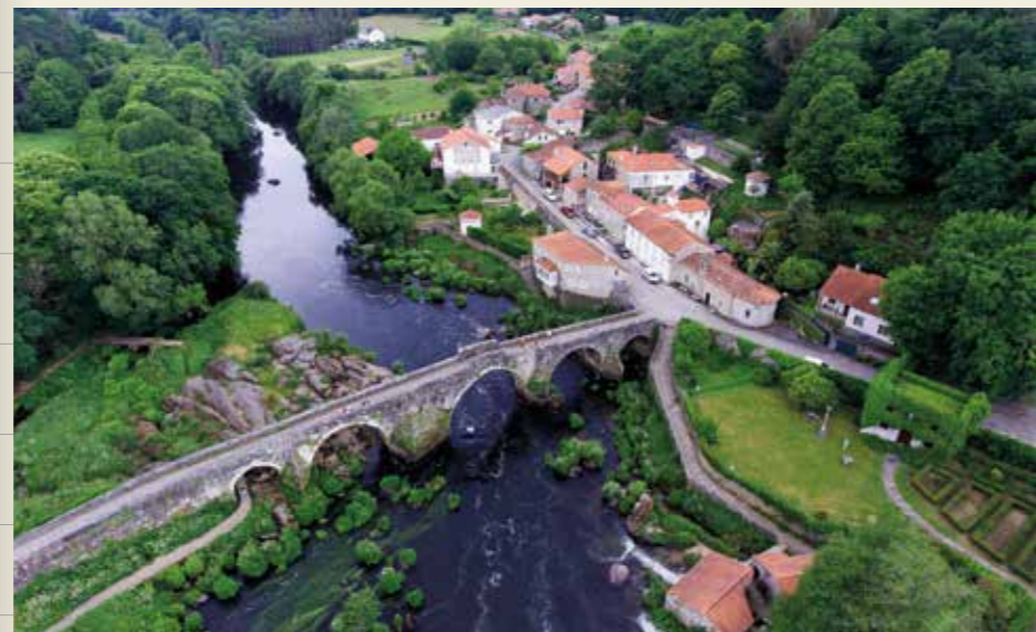
Ponte Maceira (Negreira)
