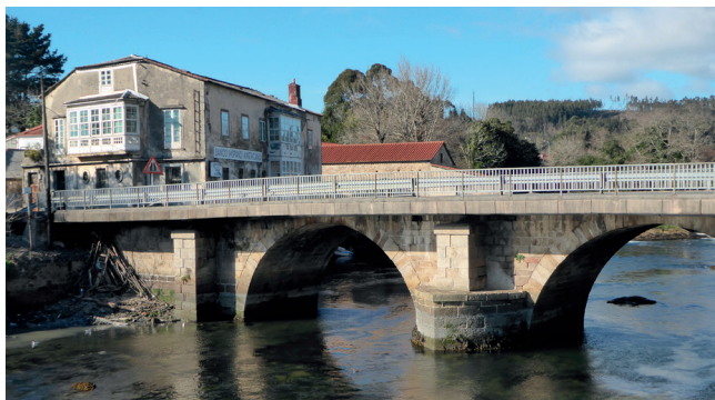
Ponte de Xubia
