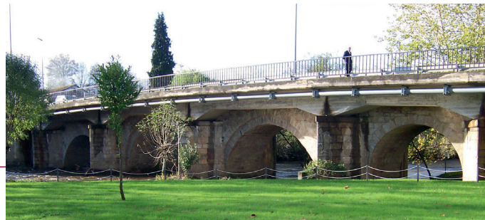
Ponte sobre o Tambre
